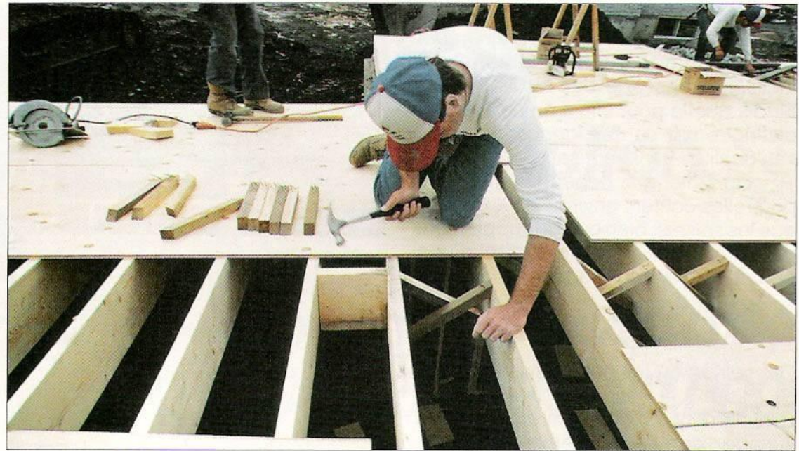
On renforce le plancher avec une rangée d'entretoises, car les solives dépassent 7 pi. Si elles dépassaient 12 pi, il faudrait deux rangées d'entretoises. Comme entretoises, on utilise des blocs de bois (à gauche) aux endroits soumis à de lourdes charges. Sur toute la largeur du plancher, il est plus économique de poser des croix de Saint-André (2 po x 2 po).
