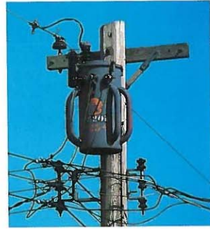
Les transformateurs au haut des poteaux réduisent encore une fois le voltage des lignes de distribution (de tension moyenne) de nos rues, c'est-à-dire de 10 000 à 120 volts.
