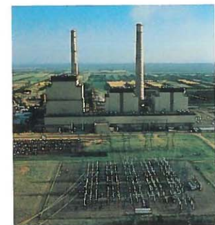
Les centrales fournissent l'électricité à des milliers de maisons et d'entreprises. Des transformateurs de haute tension augmentent le voltage de l'électricité produite, ce qui facilite son transport dans les lignes de transmission.
